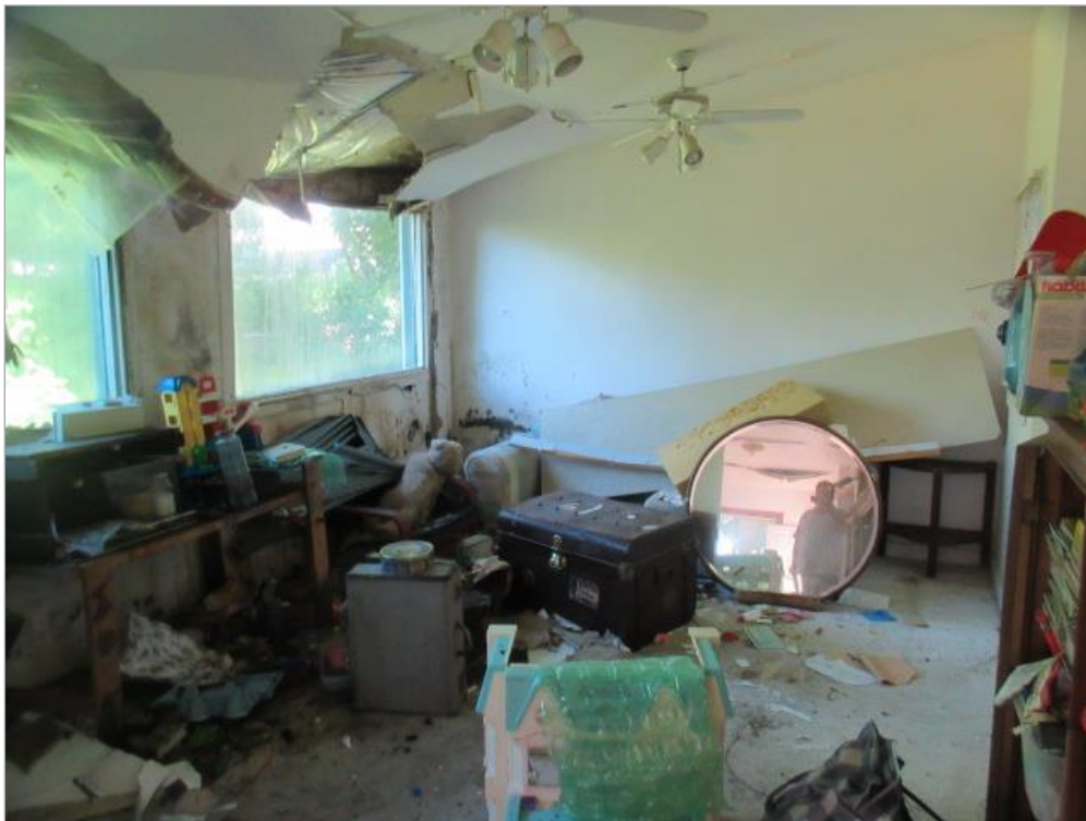
Salle familiale, rez-de-chaussée
