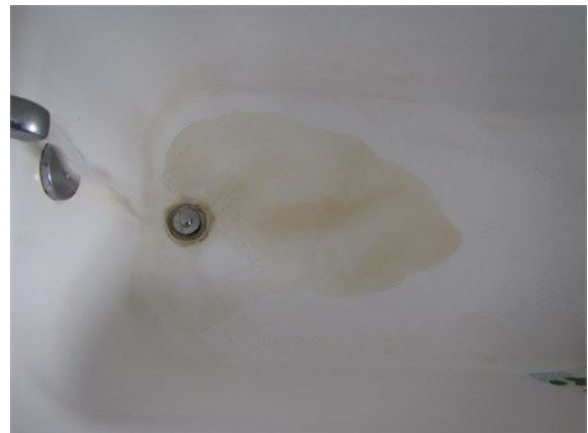
Eau rouille dans la baignoire du rez-de-chaussée en raison des conduites en acier galvanisé
