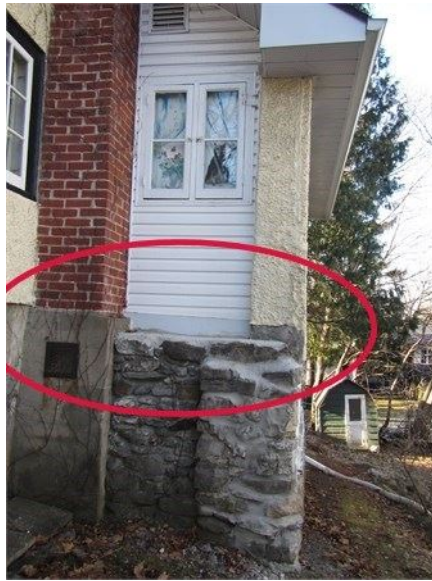
Solins à installer entre les murs de fondation et le revêtement mural
