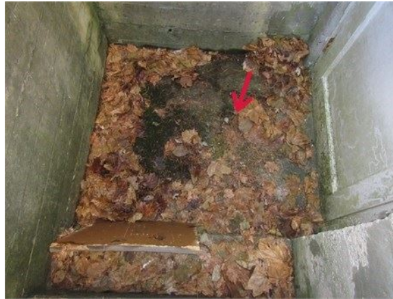
Drain à localiser au bas de l'escalier d'accès au sous-sol
