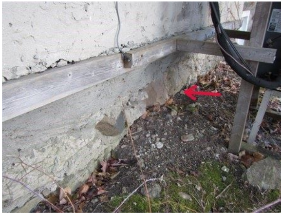
Mur de fondation latéral droit en grosses pierres
