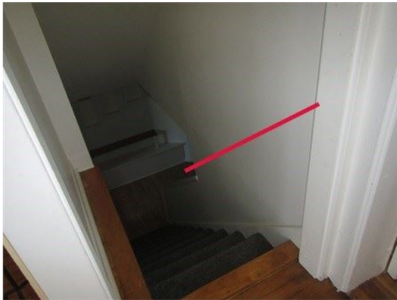
Installer une main courante dans l'escalier du sous-sol
