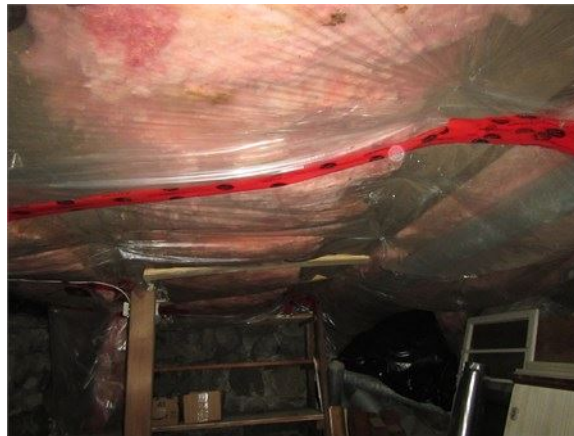
Laine et polyéthylène sous la structure dans la partie avant du sous-sol
