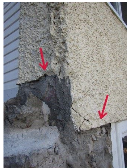
Revêtement de stuc collé aux murs de fondation, extension arrière droite
