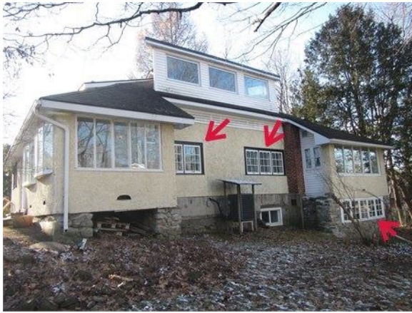
Fenêtres anciennes en bois, mur latéral droit
