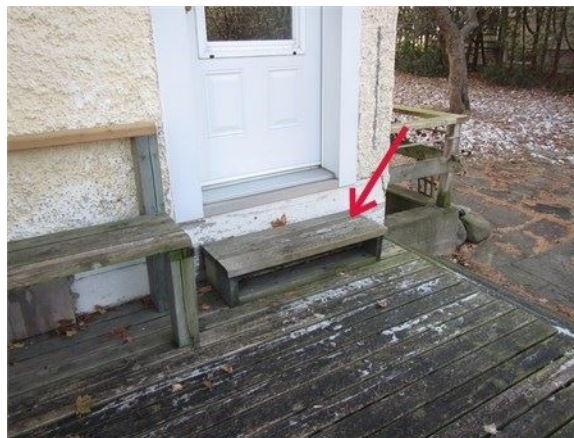
Installer un palier devant la porte de la cuisine
