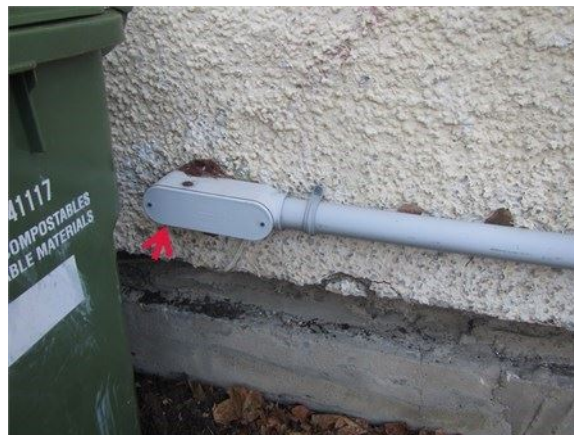
Faire percer la base du mât électrique à l'extérieur
